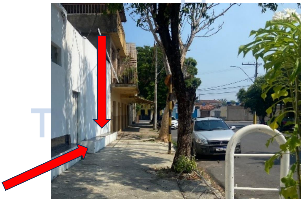
Imagem 11: Banco de alvenaria a ser demolido para construção de jardim com paisagismo, conforme projeto.
