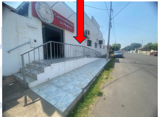
Imagens 07 e 08: Guarda corpo a ser substituído por modelo em inox, inclusive na rampa da entrada principal.
